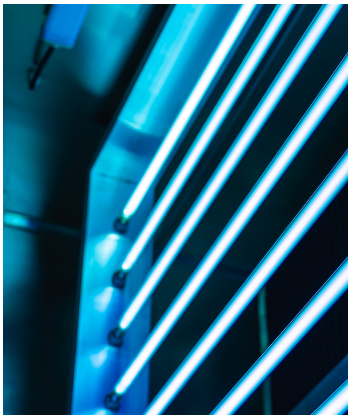
Lampade UVGI in un'unità di trattamento aria SAIVER.
